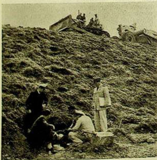
Personal de la Armada instala la válvula de salida. Se aprecia la capa de paja —en la que se ha mezclado semilla de pastos para asegurarlo contra la erosión— con que se ha recubierto el muro exterior del tranque.
