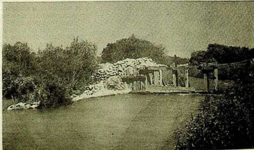
Marco partidor y aparejo de una compuerta rústica en canales de riego de la zona del Plan Chillán.
