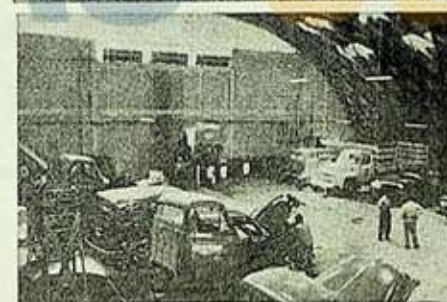
ARRIBA.—Fachada del moderno garage del Plan Chillán, construido en terrenos del Centro Nacional de Capacitación Agrícola. ABAJO.—Interior del taller de maquinarias.
