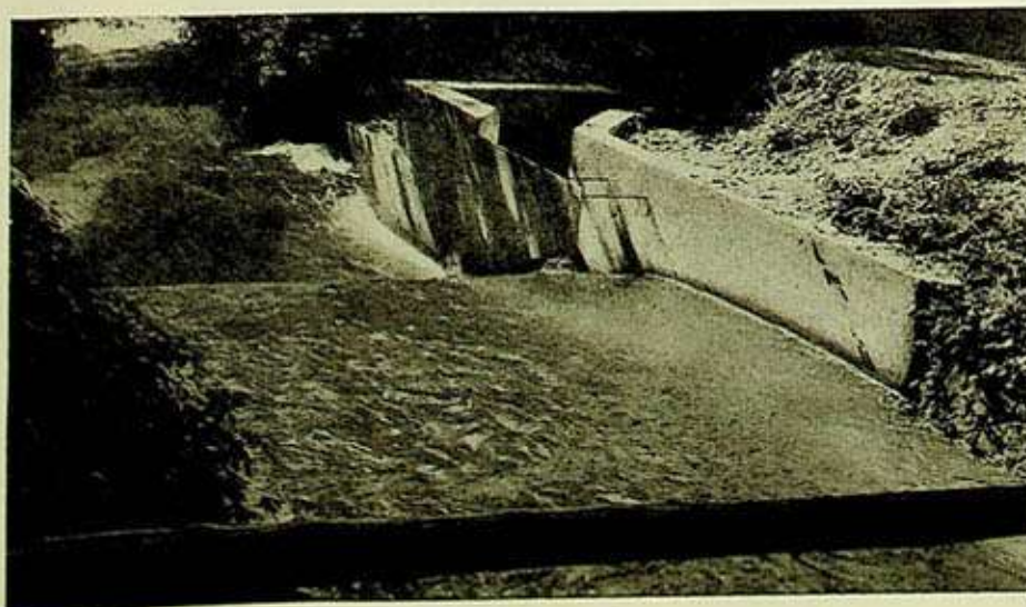
Marco partidor y aparejo de una compuerta rústica en canales de riego de la zona del Plan Chillán.
