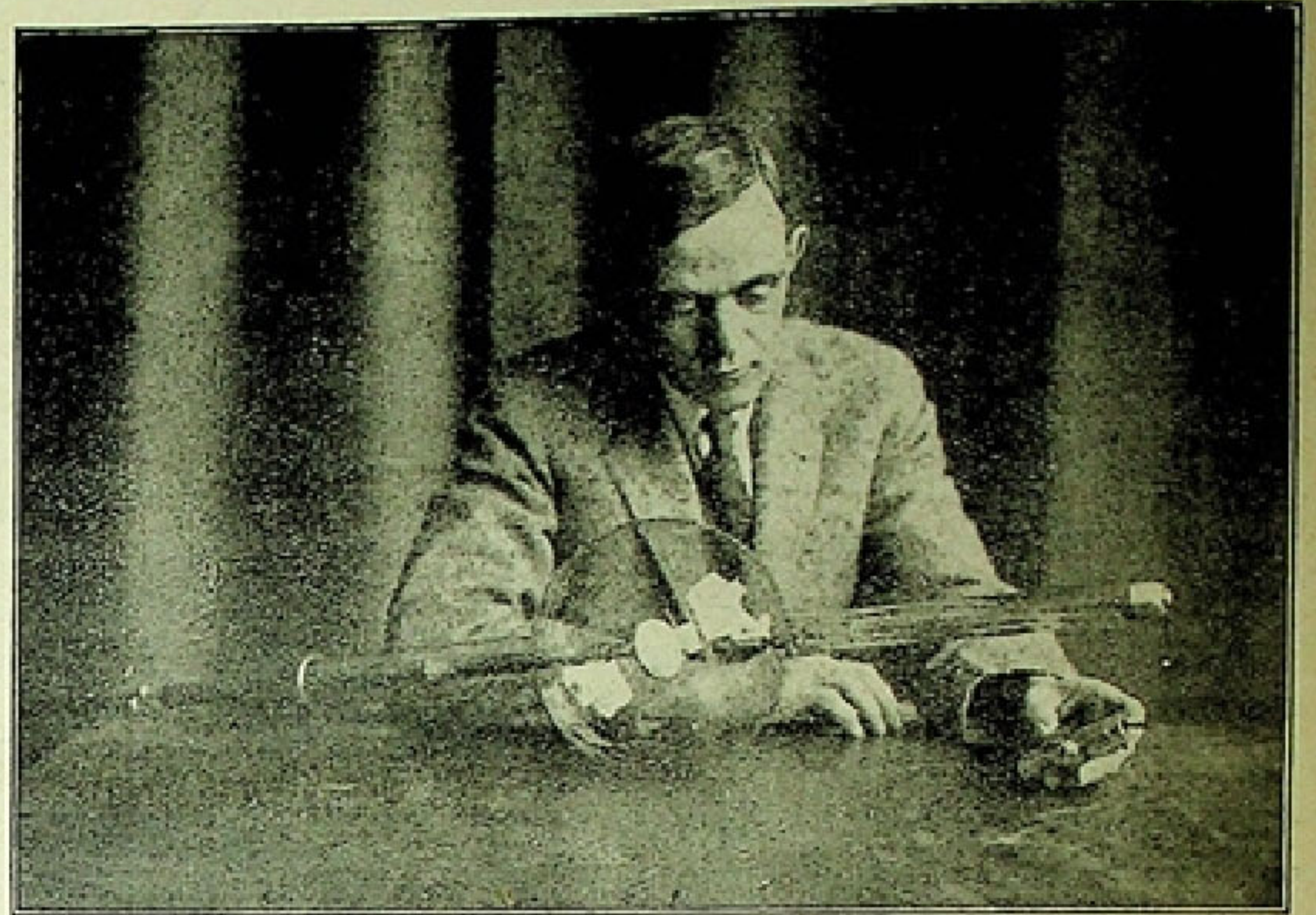
En esta ilustración se muestran el tubo Coolidge para terapia profunda y el tubo dental modelo «CDX».
