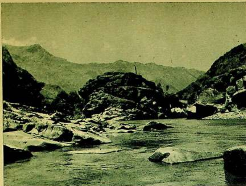
Sitio donde el Ministerio de Obras Públicas construirá el Tranque Punilla.
