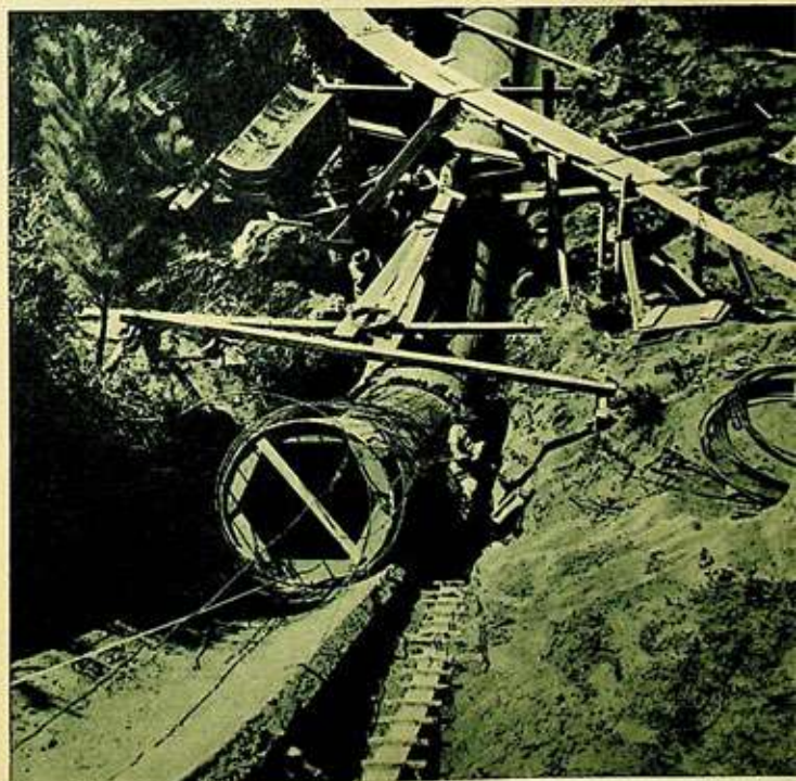
Construcción de un sifón del Canal Quillón. El Ministerio de Obras Públicas concluyó ya esta importante obra.
